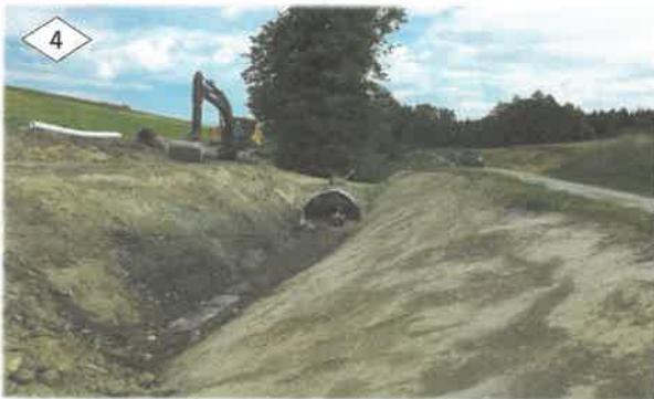
4. Installation de trois buses pour les chemins. 5. Stabilisation du fond du lit par des seuils mixtes bois-pierre. 6. Semis spécial pour remise en culture après travaux / Elargissement ponctuel du lit.
