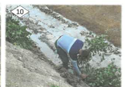
7. Expertise pédologique. 8. Réfection de drains agricoles. 9. Installation de sacs de natte coco en pied de berges. 10. Installation de ramilles anti-affouillement pour freiner les écoulements et piéger les sédiments.
