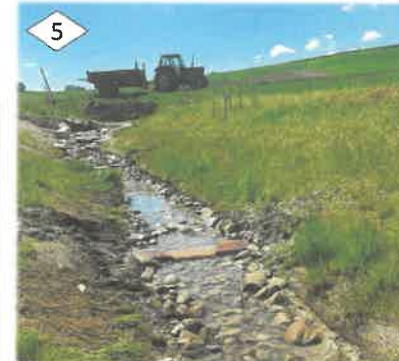
4. Installation de trois buses pour les chemins. 5. Stabilisation du fond du lit par des seuils mixtes bois-pierre. 6. Semis spécial pour remise en culture après travaux / Elargissement ponctuel du lit.
