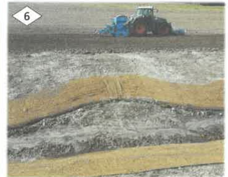
4. Installation de trois buses pour les chemins. 5. Stabilisation du fond du lit par des seuils mixtes bois-pierre. 6. Semis spécial pour remise en culture après travaux / Elargissement ponctuel du lit.
