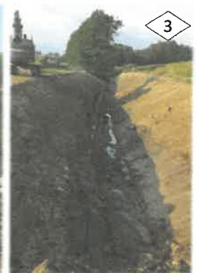
1. Travaux forestiers préparatoires du cordon boisé. 2. Décapage de la terre végétale. 3. Terrassement et évacuation du collecteur.
