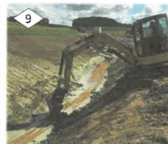
7. Expertise pédologique. 8. Réfection de drains agricoles. 9. Installation de sacs de natte coco en pied de berges. 10. Installation de ramilles anti-affouillement pour freiner les écoulements et piéger les sédiments.
