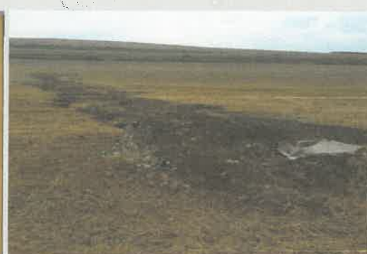
Traces d'un collecteur latéral défectueux – ILEX, 2021
