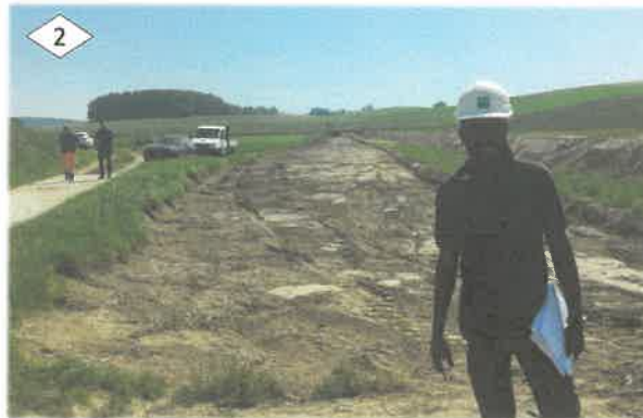
1. Travaux forestiers préparatoires du cordon boisé. 2. Décapage de la terre végétale. 3. Terrassement et évacuation du collecteur.
